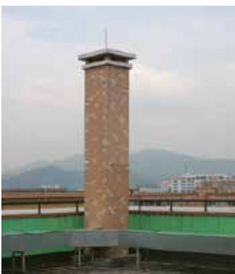
Schornstein zur Tarnung bestehender Antennenstandorte
